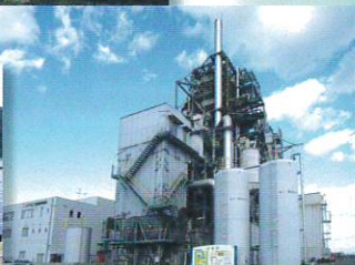
岩国バイオマス発電所
