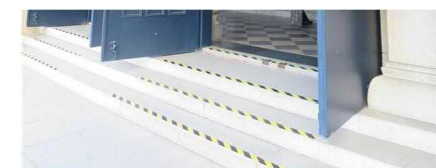
●階段(本堂) 調査による提案を受けて、階段の段鼻には、注意喚起のため端部の色の塗分けがされている(柄については継続検討中)
