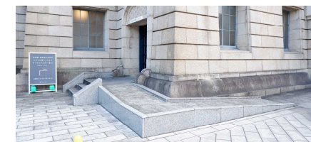
●出入口(本堂)の傾斜路 出入口の階段には傾斜路が併設されている(調査による提案を受けて、手すり設置による安全対策を2020年度中に実施する方針)
